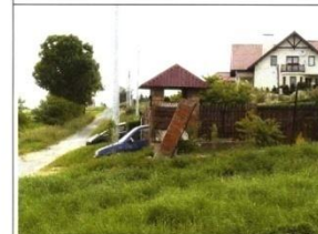
Uszkodzone ogrodzenie posesji
