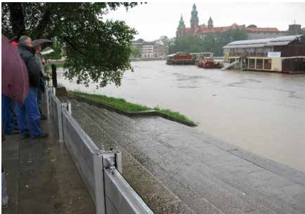
Ryc. 4. Bardzo wysoki stan wody w Wiśle pod Wawelem w maju 2010 r.; z powodu zagrożenia powodziowego zamontowano dodatkowe metalowe bariery podnoszące wysokość wałów przeciwpowodziowych. Fot. A. Bokwa.
